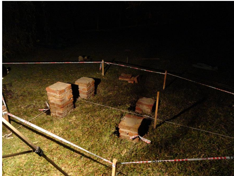
Construcción de pilares
